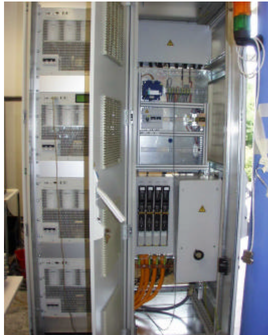
4 TopCon Netzgeräte 32 kW in Parallelbetrieb zur Speisung einer Plasmaanlage
